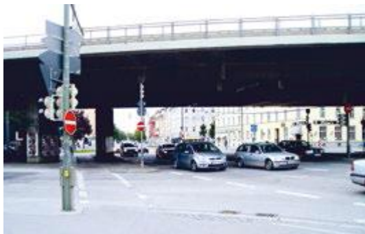
Kreuzung Arnulfstraße/ Donnersbergerbrücke (stadteinwärts)
